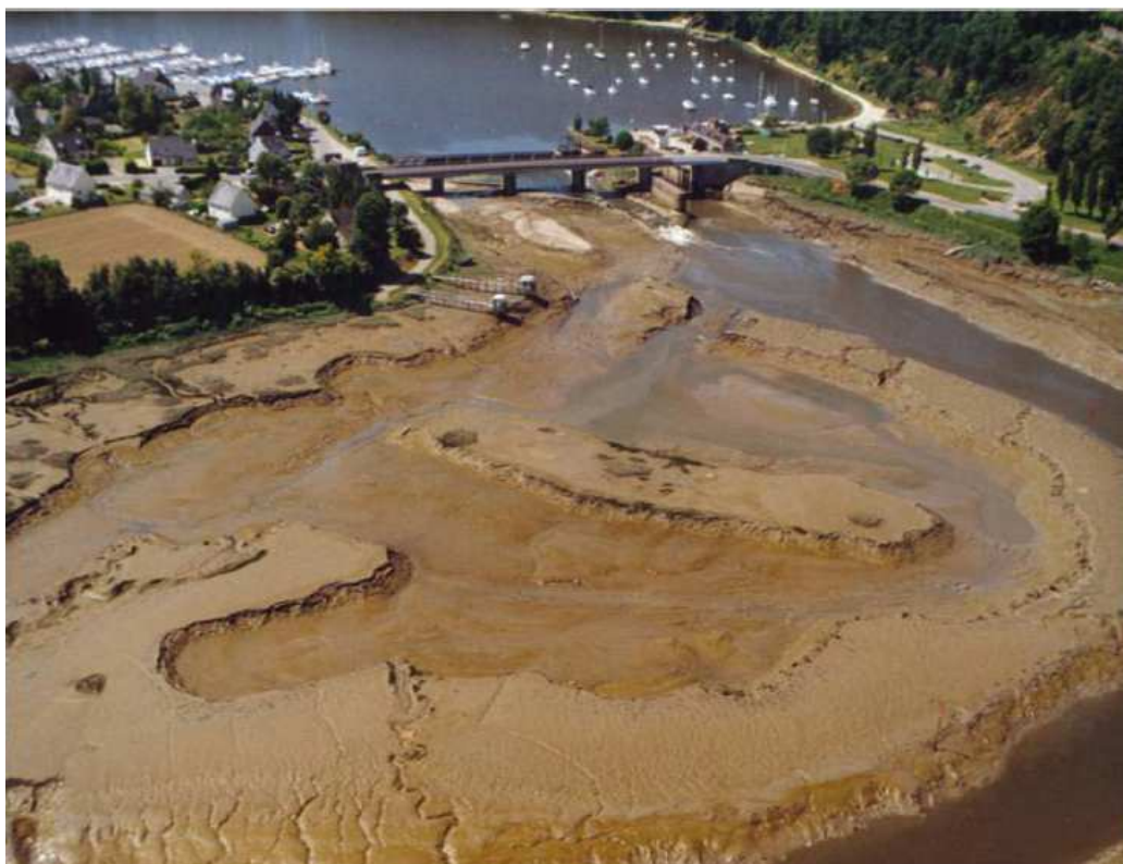
Figure 2 : Vue aérienne depuis l'aval du piège à sédiments de Lyvet après sa création en 2001
